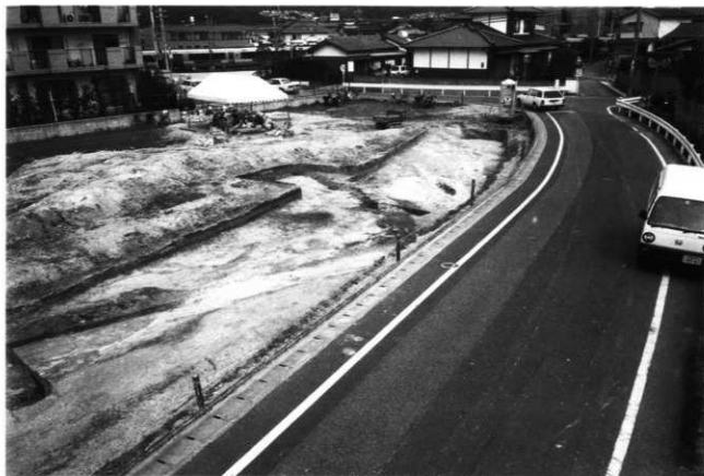
吉松本道跡第1次調査 調査区全景 (西から)
