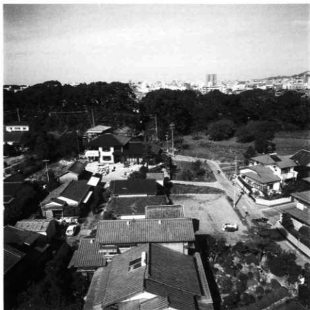
水城西門を太宰府側から望む（南東から）
