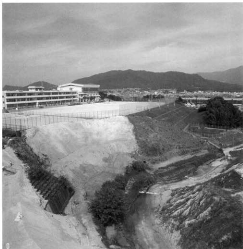
0 第10次調査区全景（西から）
