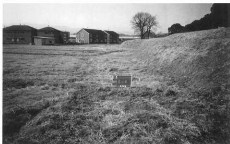
写真18 管理通路着手前 始点部（北東から）
