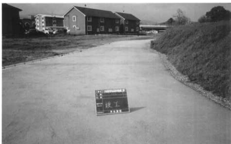
写真23 管理通路完成状況 管理通路中間部 （北東から）
