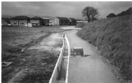
写真21 管理通路完成状況 始点部（北東から）
