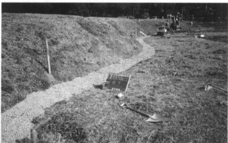
写真13 暗渠排水工布設完了状 況（南西から）
