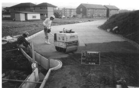
写真16・17 マサ土、セメント 混合舗装施工状況
