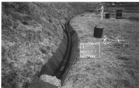
写真11 内径150mm網状管布設状 況（南西から）
