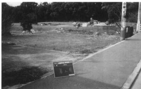
写真25 管理広場着手前 (南から)
