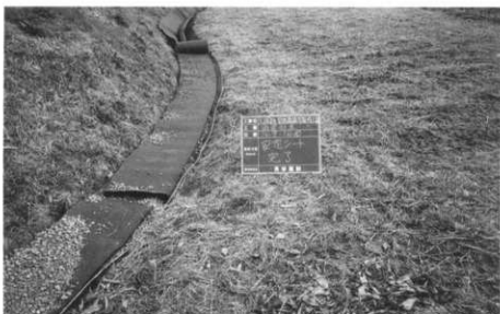
写真12 網状管の周辺に粒径20～ 40mm程度の碎石を充填し 土木シートで覆いさらに、 地盤面まで碎石を敷く。 （南西から）
