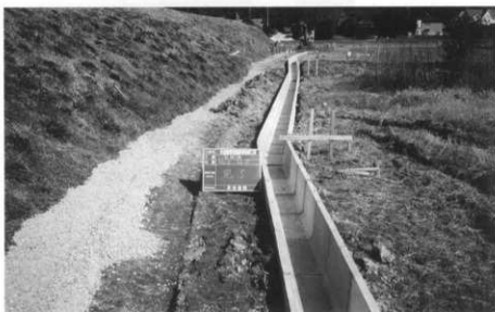
写真14 U字型側溝布設状況 (南西から)
