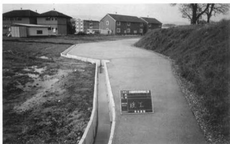
写真22 管理通路完成状況 1号瓦窯跡付近 （北東から）
