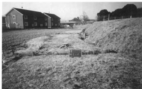
写真20 管理通路着手前 中間部（北東から）
