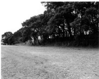
水城跡テラスから土塁を望む（東から、奥は高速道路）
