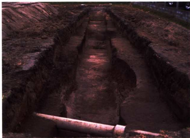
第188次調査区西トレンチ全景（北から）
