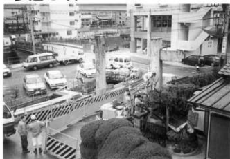
Pla71-1 工事施工前
