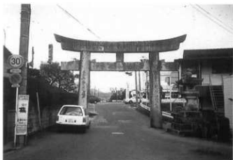
Pla72-5 改修前鳥居 (北より)
