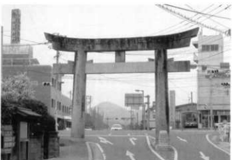
Pla72-6 改修後鳥居 (北より)
