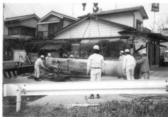
Pla72-1 東柱撤去時 (西より)
