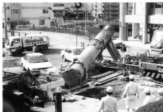
Pla71-2 西柱撤去時
