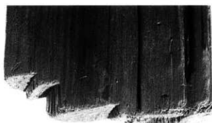
部材端部切断状況
