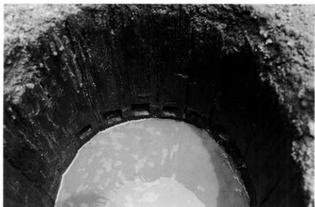
SE010井戸枠詳細状況（西から）
