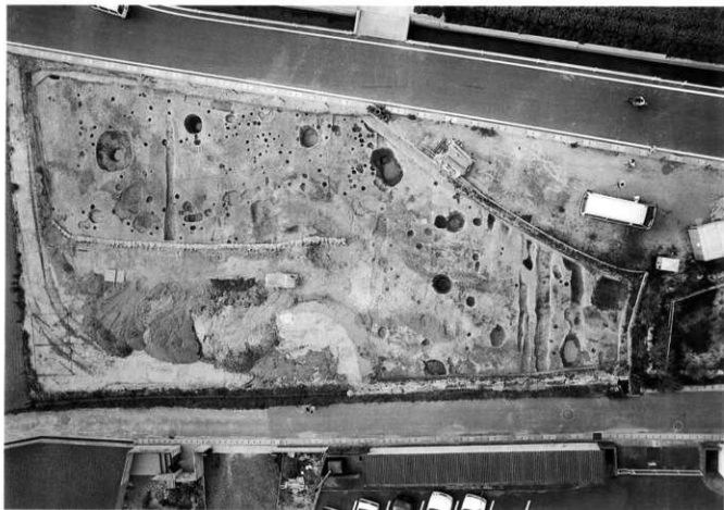
第199次調査北側全景（南から、空中写真）
