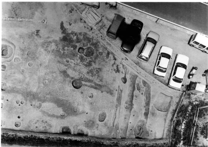
第199次調査南北道路全景（南から・空中写真）
