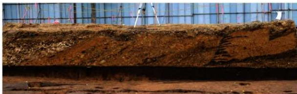
4 洗江家脇門周辺の盛土(西→) 写真右側に版築の互層が見える。盛土は南から北へ延びる。
