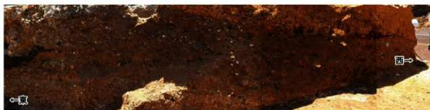
1 SE434検出断面(北東→) 盛土が東から西へ積まれるため、西へ向かって傾斜することに注意。地形は西高東低である。
