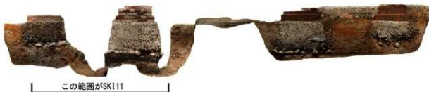
3 SB03断面（南一） 基礎は栗石とコンクリート。SK111の上に立てられた部分は基礎が深い。
