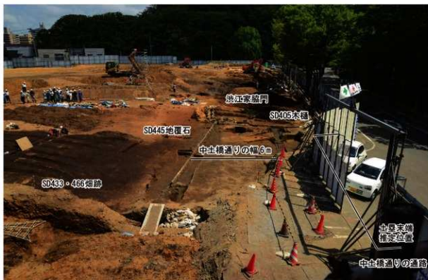
2 中土橋門枳形(南一) 写真中央に写るSD445を面する地覆石列が、流江家敷地と中土橋通りの境界となる。写真右の現場入口シャッターの敷設位置が、旧県立美術館からのびる土塁の末端と重なる。写真左の黒色土上にある短い溝群は、流江家造成直前まで営まれた細跡SD433・466。
