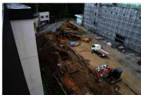
4 SF01土塁西-北西部分 (南→)
