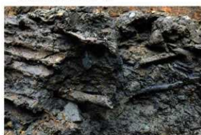
5 土留柵を結束するツタ (西→)
