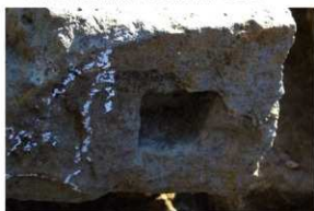
7 SB305地覆石 小口に納穴が切られる。全て雌なので連結には木製の契りを使ったと推定。
