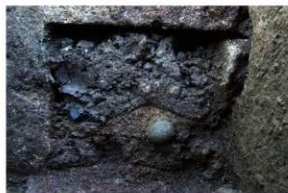
6 SB305集水枡入水口層位 (北→) 入水口に詰まる土砂は上層が粗く下層が細かい。
