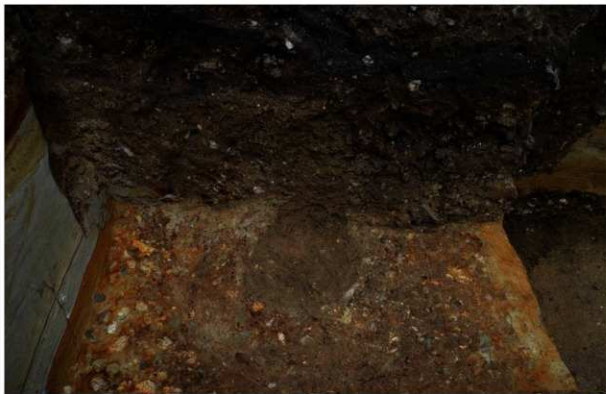
1 SA28柱穴断面(南一) 盛土土壘下の布地業を掘り込む。
