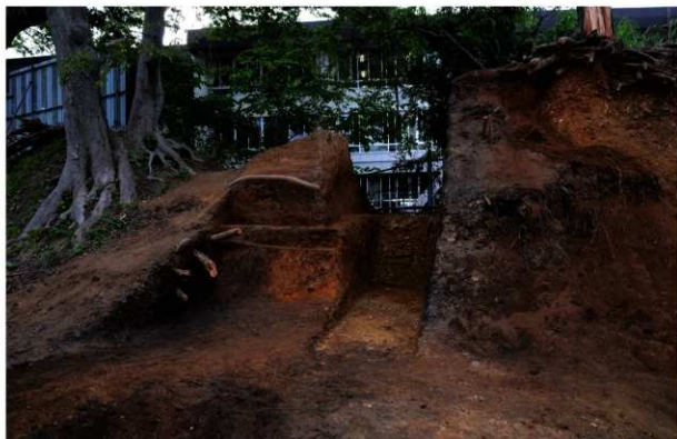
2 SF01保存範囲との境界に設定した第6トレンチ (東→) 写真左側のケヤキは保存樹である。ケヤキ右側の鞍部が保存境界。調査区側は地山を削り出した土塁であるが、保存区域側は盛土の可能性が高い。切られたケヤキの根には樹木医が治療を施した。
