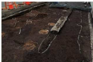
写真 15 木造市営住宅基礎検出状況 (西から)
