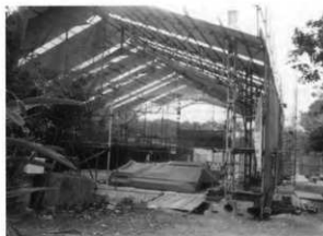
16. 素屋根完成 (東側より)
