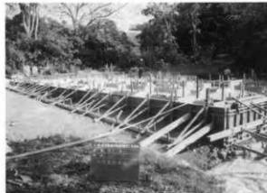
21. 土間型枠設置 (北西側より)
