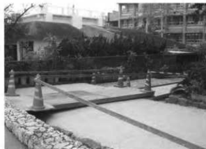
26. 養生期間中の仮設通路 (奉円館前)
