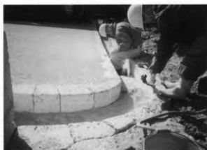
32. 側溝石敷き (参詣道スロープ北側)
