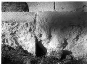
15. 排水溝設置 (接着剤補強)
