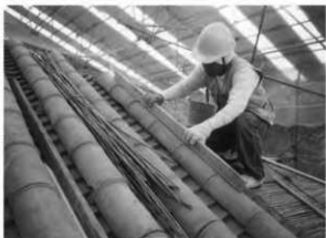
77. 丸瓦葺き（定規にて通りを出す）
