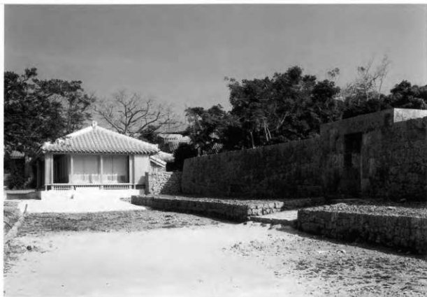
1. 竣工 西方より見る
