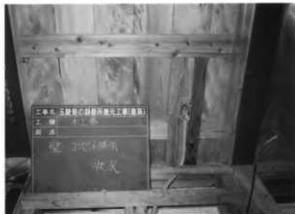
51. 内壁埋込コンセント補強
