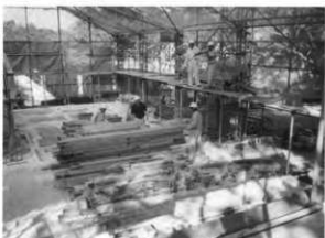
40. 木材現場搬入 (南東側より)
