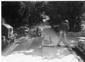
21. 既設舗装撤去後、仮設通路設置 (奉円館前)
