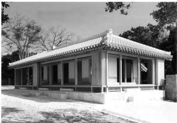
2. 竣工 北西側より見る
