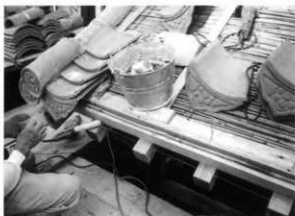
75. 軒先瓦葺き（瓦座には亜鉛釘に鋼線を巻き付け）
