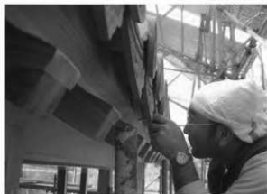
81. 瓦座処理（軒平瓦と瓦座の隙間・瓦座表面を漆吹で仕上げる）
