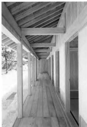
8. 竣工 廊下 (西側より見る)
