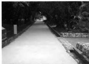
25. 舗装完了 (奉円館前)
