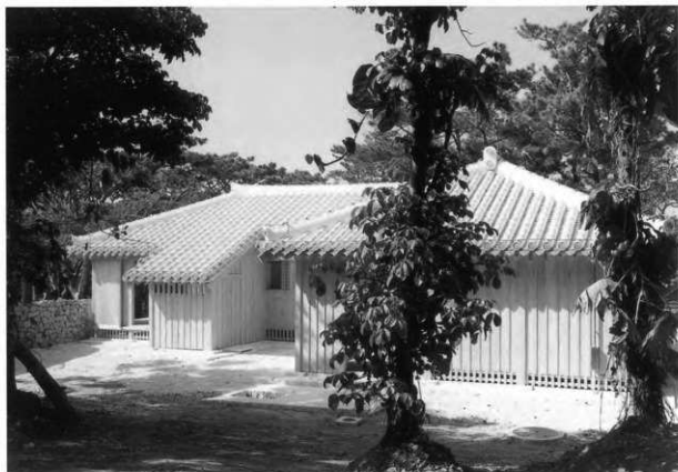
4. 竣工 南側より見る
