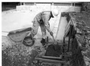
27. 説明板基礎設置 (コンクリート打設)
