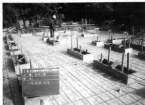
22. 土間鉄筋配置 (北東側より)
