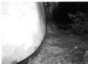
82. 設備幹線 (玉腰石牆南側)
