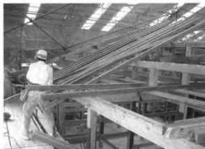
45. 垂木取付 (東面)
