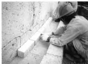
33. 踏石支石設置 (西面側溝)
