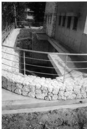
3. 吹抜け上部 (南側より)
