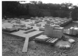
25. 礎石据付 (北東側より)
