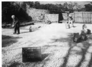
20. 土壌処理剤散布 (東側より)
