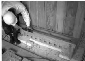
53. 雨戸戸袋設置
