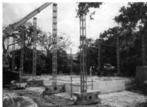
15. 素屋根建設 (北西側より)
