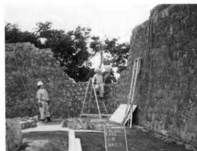
4. 石積解体 (背面)
