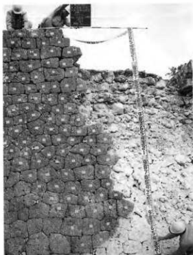
3. 解体前検測 (前面左側)
