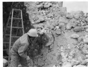
5. 石積解体 (前面左側)
