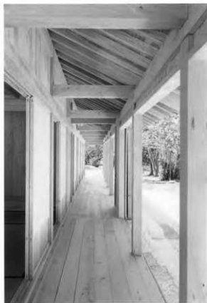
9. 竣工 廊下 (東側より見る)
