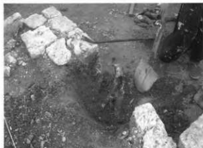
13. 切り株除去 (基壇部分)
