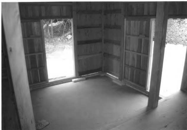
7. 竣工 台所土間
