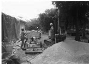
22. 舗装材配合状況
