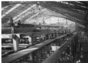
43. 小屋組 (北東側より)
