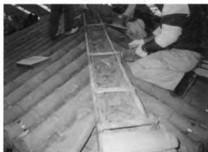
79. 隅棟（砕瓦と葺土を詰め、その上に平瓦を重ねる）
