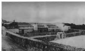
修理後 墓室方向を見る
