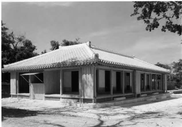
3. 竣工 北東側より見る
