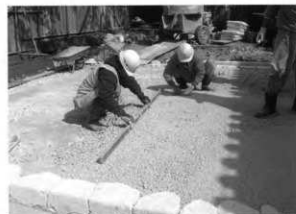
88. 透水性舗装 (参詣道スロープ)
