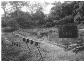
11. 工事着手前 (北東側より)
