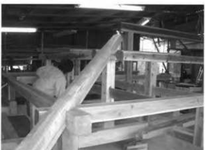
37. 小屋仮組み (同上)
