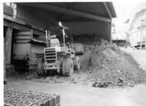
68. 原土保管状況
