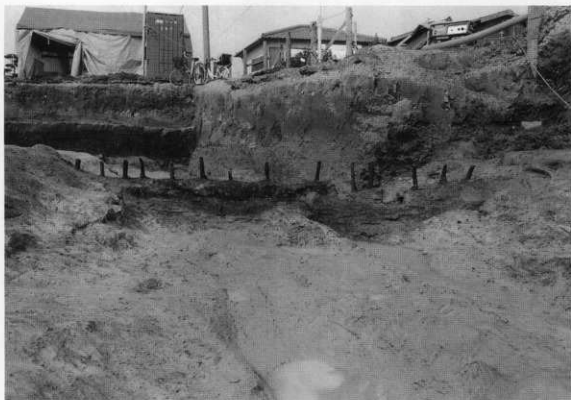
120SD020杭列 (南から)
