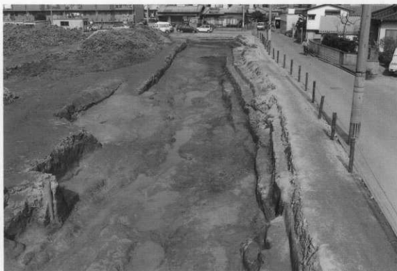
条194-2次調査完掘状況（南半部、南から）
