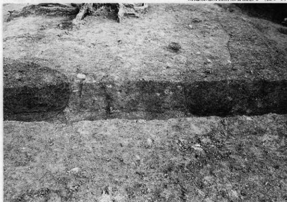
南辺築地南側溝土層観察2 (西から)
