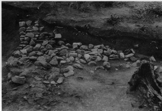
北側Ⅱ段斜面葺石崩壊状況（北から）
