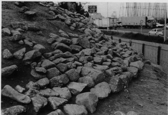
EトレンチⅡ段斜面葺石（南東から）
