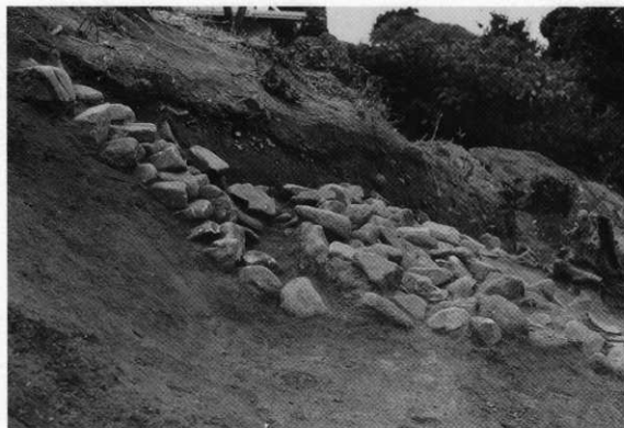
北側Ⅱ段斜面葺石崩壊状況（側面、東から）
