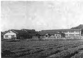
Fig. 3 第一期工事竣工(昭和17年3月)
