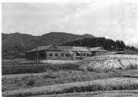
Fig. 2 本館移築完成間近(昭和15年9月)
