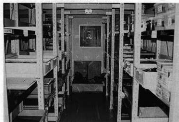
第32図 収蔵庫内の給排水設備
