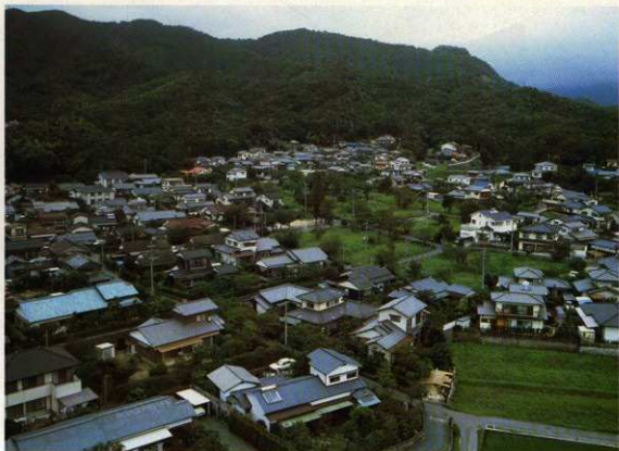
辻遺跡(文化ふれあい館建設予定地)の遠景(南西から)
