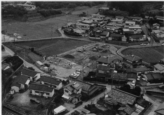
御笠団印出土地周辺遺跡第8次調査 調査地遠景（北から 空中写真 中央工事中の部分）
