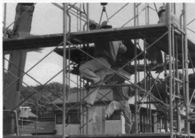
写真22 現地組立作業
