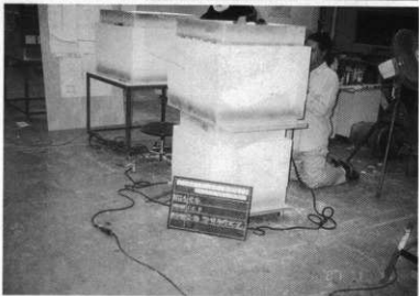
写真10 壁面部材製作
