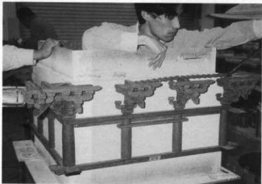
写真13 部材の取り付け
