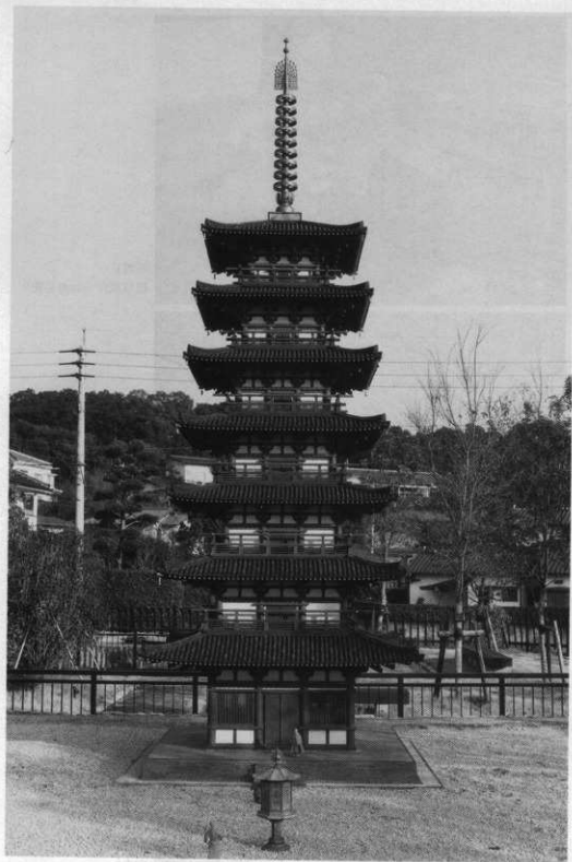
写真2 筑前国分寺七重塔模型完成状況
