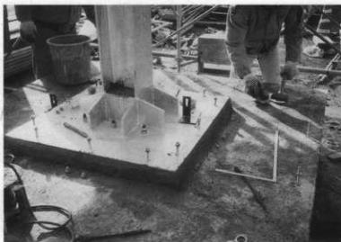
写真21 鉄製H鋼材を立てる
