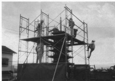
写真23 現地組立作業
