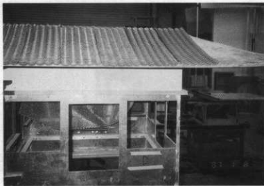
写真15 屋根瓦の固定
