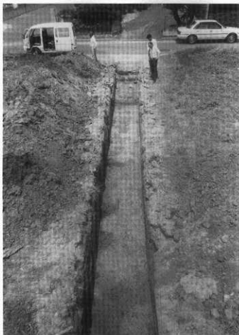
18-163地点トレンチ (西から)
