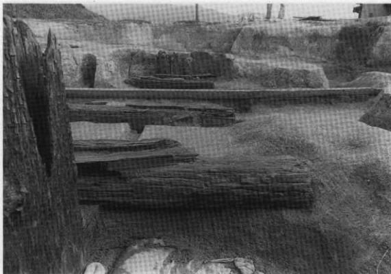
第17次調査横種枕木配列状況（西から）
