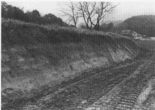
Fig. 22 第11次調査地現況
