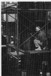
左柱コンクリート補填
