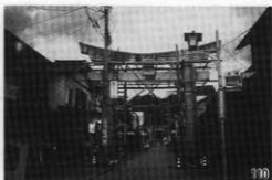
撤去前西より
