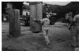
右柱除去状況
