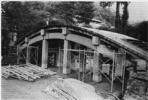
三の橋（西より）
