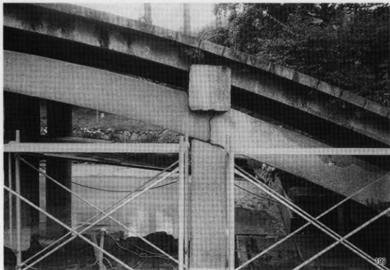
三の橋 橋脚部分
