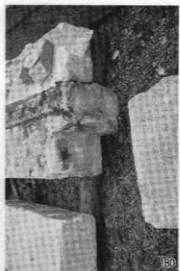
右柱木接合部
