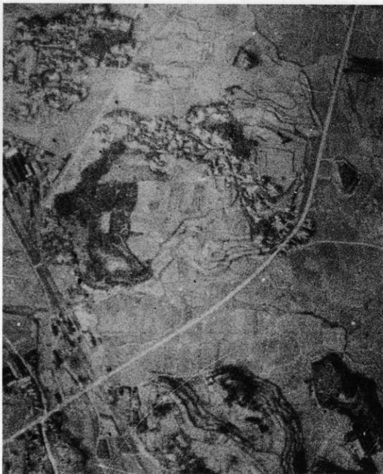
Fig.9 大きく変貌してしまった般若寺跡の旧景 (昭和23年) 約1:5200
