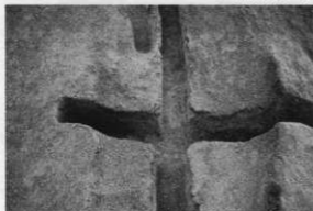
1号窯々体断割状況（北から）
