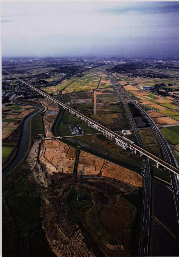
堺道下遺跡全景（南から）
