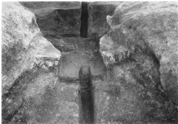
4号窟跡 | 面煙道部たちわり状況 (焼成部側より)
