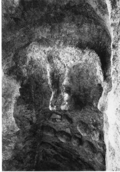
4号窯跡煙道部構築状況（煙道部上位より）
