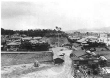
I 6AYP地域遠景(北西から)
