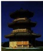
■復元建物（八角形建物跡）
