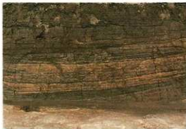
深迫門礎検出の版築土壘 (厚さ5~10cmの粘土を吹き積りながら積み上げたもの)
