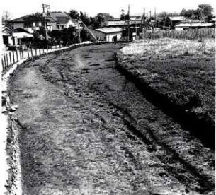
E区道路状遺構 (全景)
