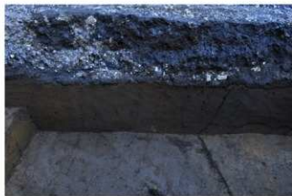
7. Aトレンチ南壁中央土層断面（北から）
