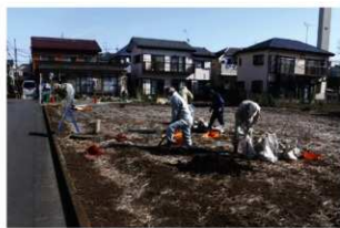
写真97 作業風景 (南から)
