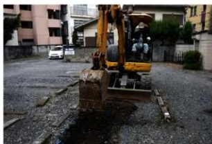
写真 83 表土掘削作業風景（南から）
