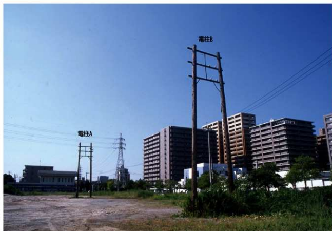
(1) 木製鳥居型電柱 (南西から)
