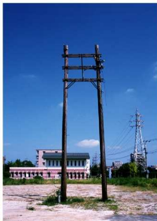
(3) 木製鳥居型電柱A (南から)
