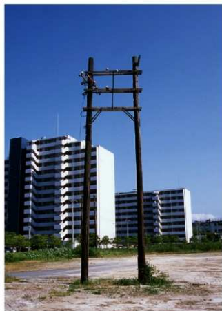
(2) 木製鳥居型電柱A (北から)
