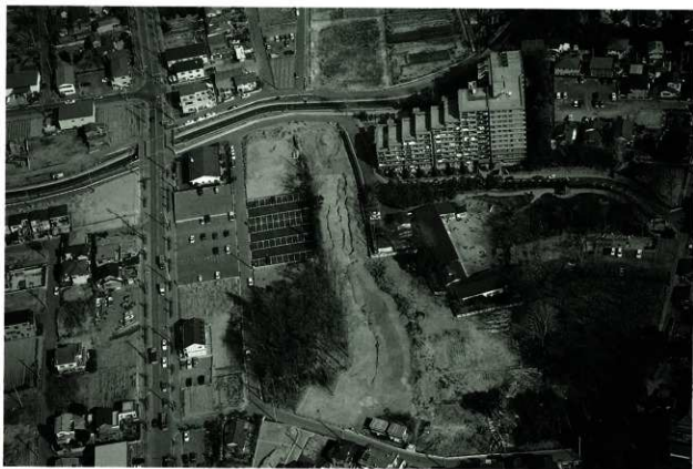
航空写真（西から）
