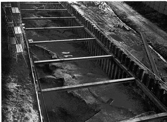
NR3003 全景 (北東から)
