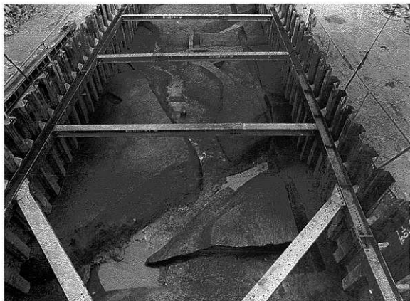
-10--6ライン区層上面(南から)
