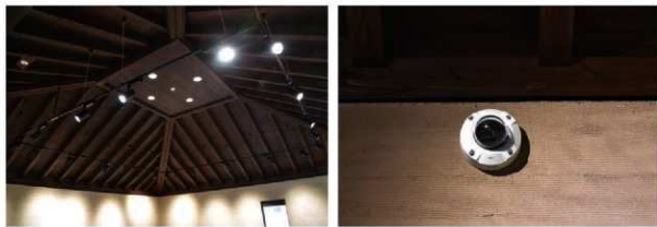
第 139 図 電気設備設置状況 (左: 展示室内照明 右: ドーム型カメラ)
