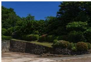
第85図 山内通路に伴う石垣(西から)
