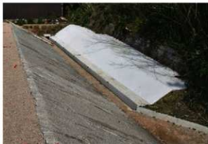
第152図 用地側溝整備状況
