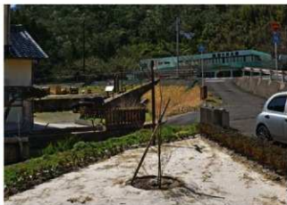
地盤整備（2）（カツラの木植樹 北東から）
