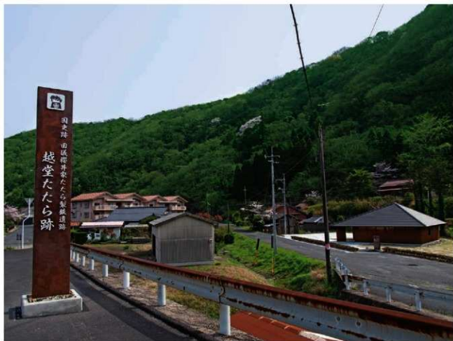
ガイドンス施設整備完了状況（3）（南西から）
