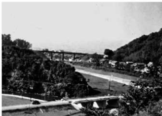
越堂たたら跡周辺から口田儀のまちなみを望む (南東から) (昭和 36 年)
