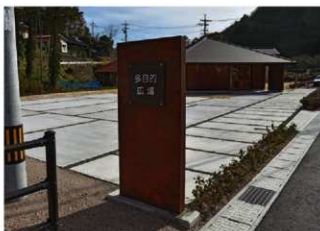
施設案内看板（多目的広場横）（2）（北から）
