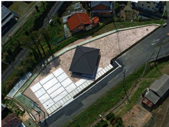
ガイダンス施設整備完了状況 (1) (北から)
