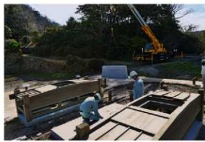
第108図 製鉄炉・天秤ふいごの設置位置確認(左)と設置状況(右)(令和4年度)
