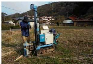
第64図 建物配置予定地周辺の地盤調査状況
