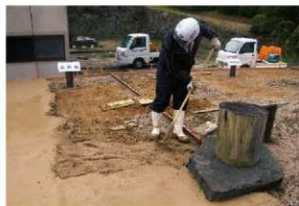
第107図 真砂土舗装施工状況(令和3年度)
