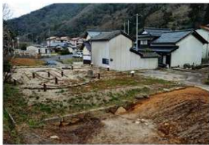
第100図 高殿南側地盤整備完了状況（令和2年度）
