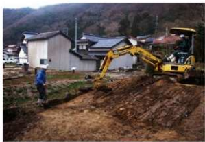
第99図 高殿南側地盤整備工事状況（令和2年度）
