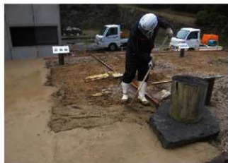
真砂土舗装施工状況（西から）
