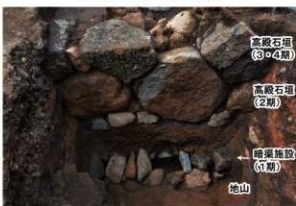
第74図 高殿南面石垣の造り替え痕跡と暗渠施設
