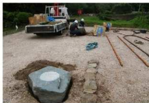
第92図 遺構表示設置工事状況（平成30年度）
