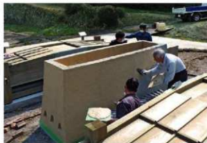
第113図 製鉄炉の珪藻土仕上げ (左) (令和4年度) と菅谷鉦の製鉄炉 (右)
