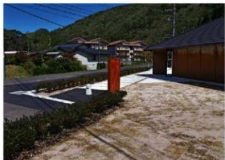
地盤整備（1）（低木植栽 南東から）
