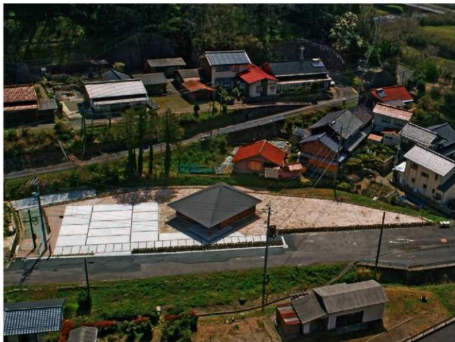
ガイダンス施設整備完了状況 (2) (西から)
