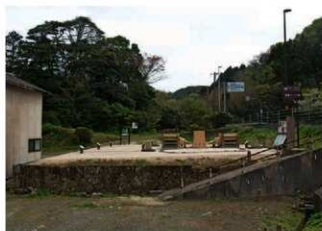
現地整備完了状況（3）（北から）
