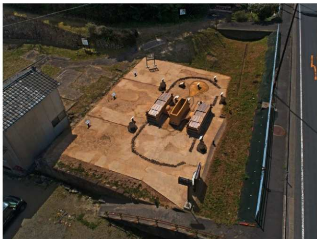
越堂たたら跡全景 (整備完了後 北西から)
