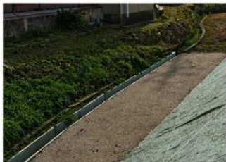
用地側溝整備（2）（北から）
