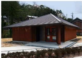
建築外観（1）（北西から）
