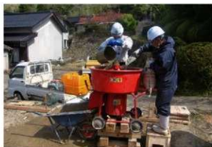
第107図 真砂土舗装施工状況(令和3年度)
