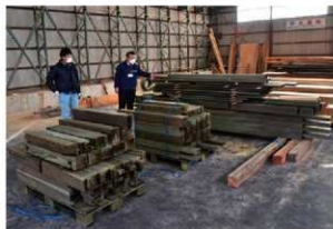
第115図 防腐剤を含浸処理した天秤ふいこの部材 (左) と組み立て状況 (右) (令和4年度)
