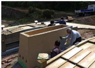
製鉄炉復元製作状況（2）（珪藻土仕上げ）
