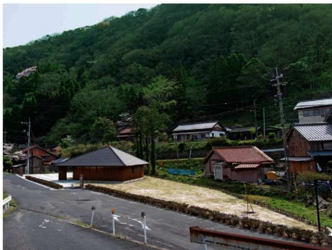
ガイドンス施設整備完了状況（4）（南西から）
