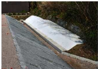
用地側溝整備（1）（南から）
