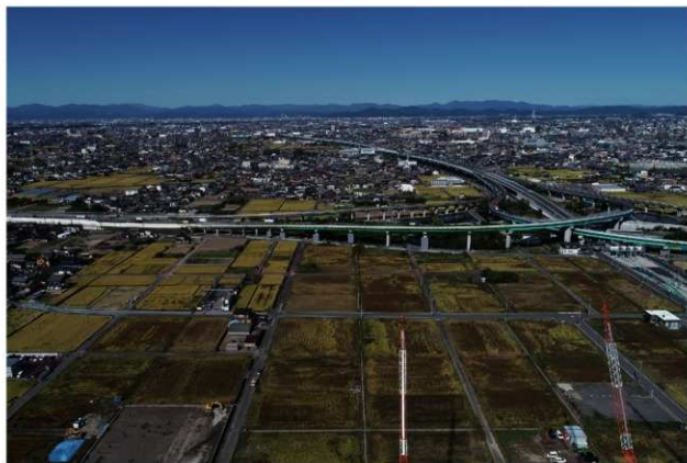
1. 1工区 西半部 調査区北部（上が北）
