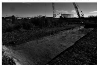
69. 3工区 調査区 土層断面状況 1 (北西から)
