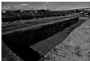
73. 4工区 調査区 土層断面状況2 (南東から)
