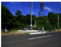
②鉄塔管理用平坦部
