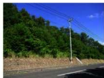
①市道杉沢線側の法面
