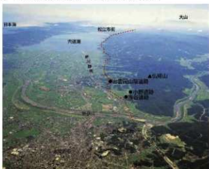
図 1-2 空中写真から見た古代道など(西から)
