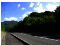
㉔市道杉沢線側の法面
