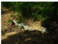
⑭仮設土留め
