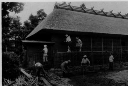
67 壁工事（荒壁塗）
