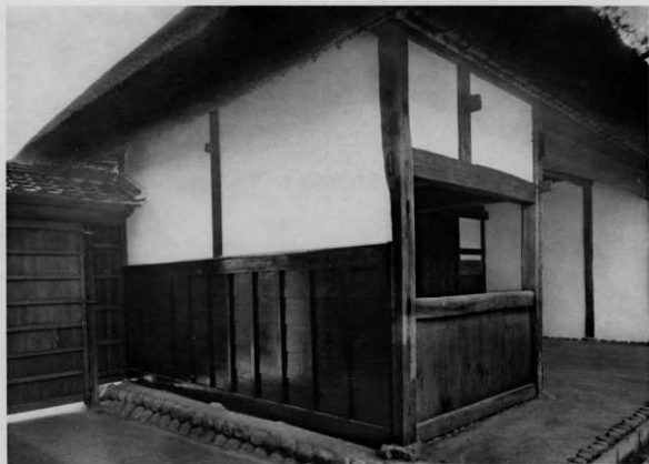
3 竣工 背東側面
