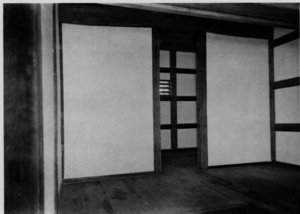
9 竣工 下郎部屋南面
