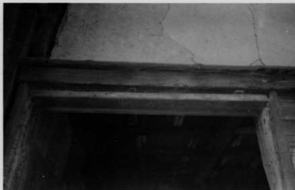
41 同 上 南より第一間藁の子下見板張の上胴縁下端に 藁の子切断面が残っている
