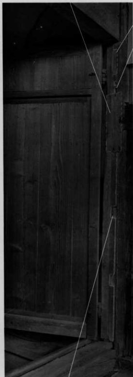
板壁の板溝及び胴縁穴
