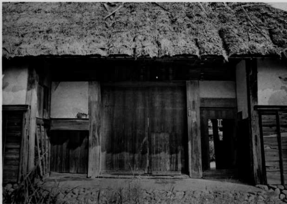
21 修理前 長屋通り
