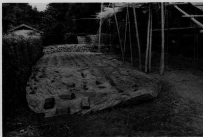
65 壁工事（壁土練込）
