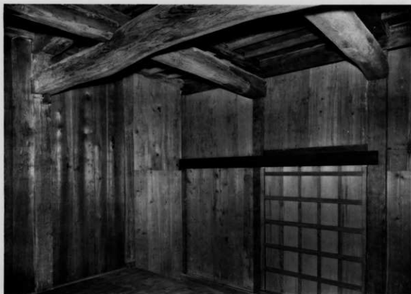
12 竣工 前倉北面
