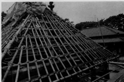
60 屋根（野地完了）
