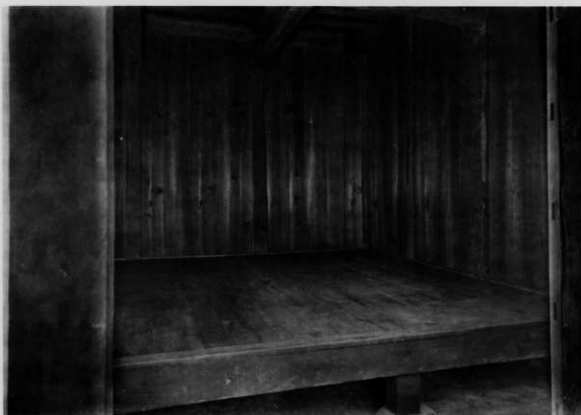
11 坡工 前倉南面
