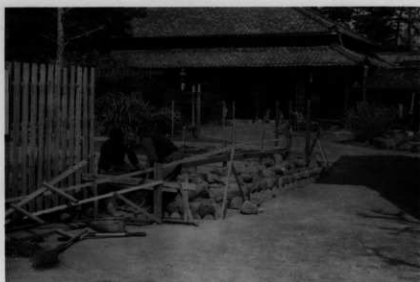
45 解体（柱礎石据付）
