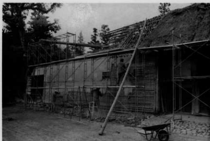
42 解体 (正面西側)
