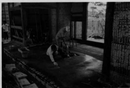
47 基礎（長屋通りコンクリート叩）
