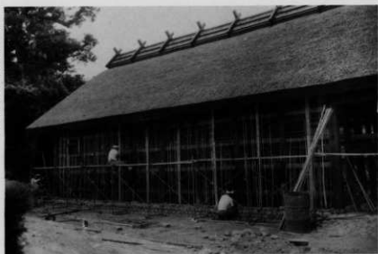
66 壁工事（小舞掻き）
