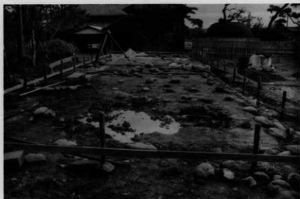
46 基礎（礎石据付完了）
