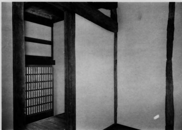
10 坡工 下郎部屋北面
