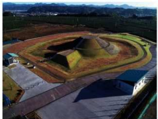
令和5年整備工事完成 南西から
