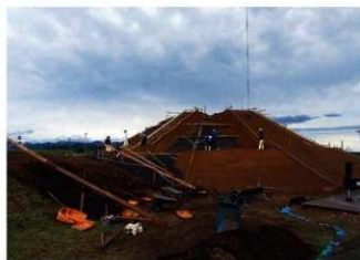
平成30年墳丘盛土工事の様子
