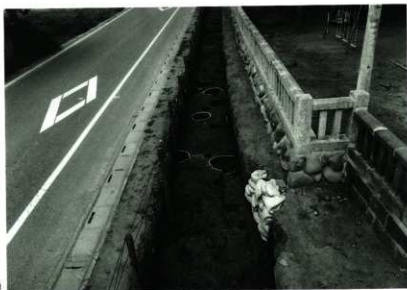
C区全景2(東から)
