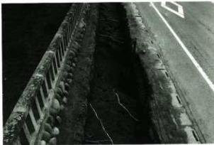
道路状遺構掘り方
