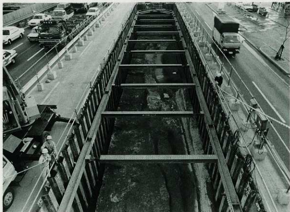
9区 溝16・19 (北から)
