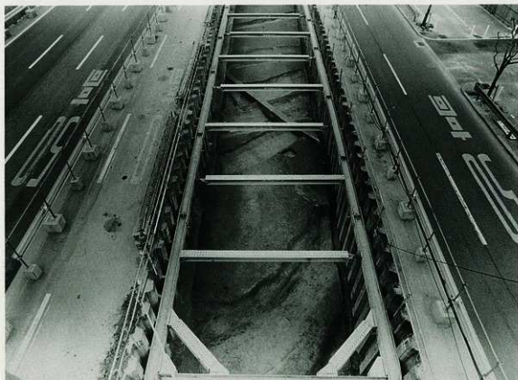
3区 手前から溝3・6・8・5・10・9・4 (南から)
