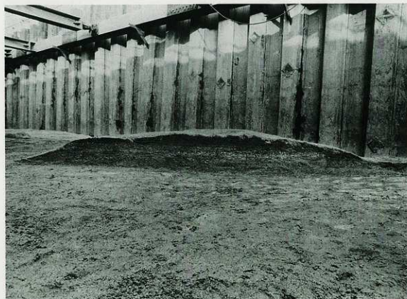
同上 断面(西から)
