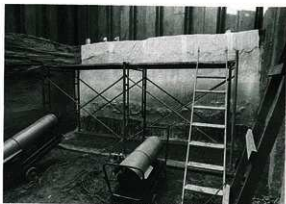
④ ジェットヒーターによる接着剤の乾燥
