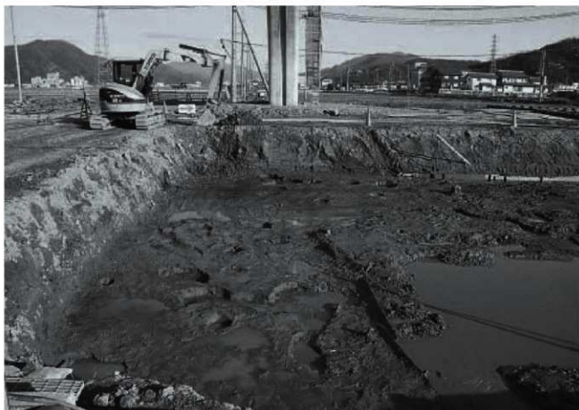
(2) 立会2区全景 (西より)
