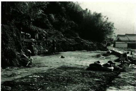
田井ヶ迫地区 石垣除去作業
