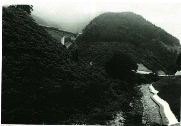
調査開始前の状況 西から
