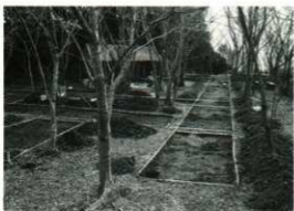
I b区表土除去後
