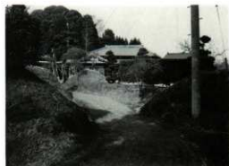
V 郭南西部端の土塁状遺構 (南西から)
