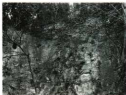
(ウ) 地点中央～左側壁
