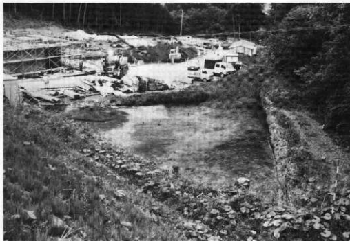
調査後近景 (南西から)
