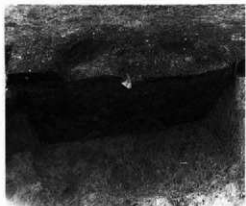
e. HV-56ピット 埋土断面
