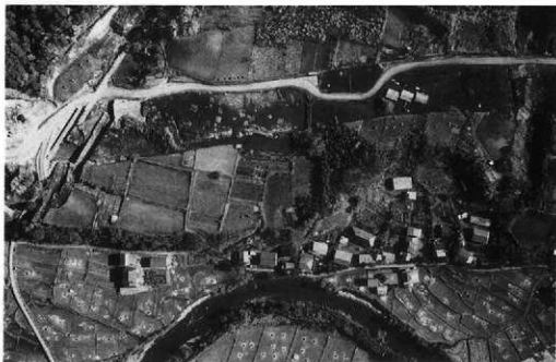
a. 北西から (調査区全景)
