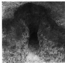
e. 煙道部掘り方
