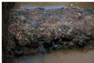
⑧. SX15 暗渠跡検出状況 (南から)
