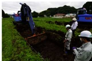
③. 1区掘削風景 (北西から)
