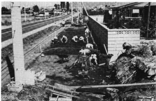
b. 遺構検出作業状況東側 (A・BⅡ区)
