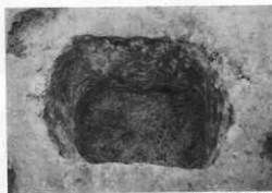
ビット完掘状況
