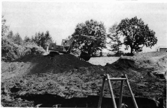
重機による表土除去作業(ⅢF区)
