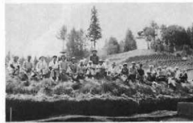
現場作業員のみなさん
